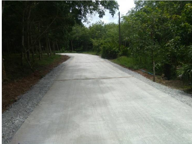
โครงการก่อสร้างถนน คอนกรีตเสริมเหล็กสายนางหลงโค้ง-พานทิง หมู่ ๔
